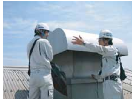
建屋屋上の全てのファンを確認
