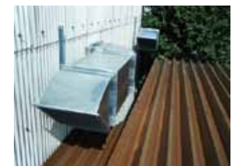
ダクト工事後
