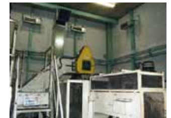
脱臭装置取付後
