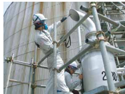
スクラバー脱臭装置出口
