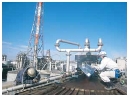
アスファルトタンク臭気採取風景
