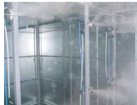
ダクト内スプレー噴霧
