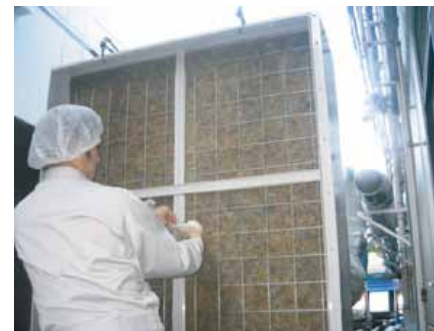
ダクト出口臭気採取
